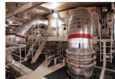
1 压力容器上部から出ている主蒸気管。压力容器が傾けば、数十センチのズレ・歪みが生じて破断し、冷却材喪失→炉心損傷に直結する。
