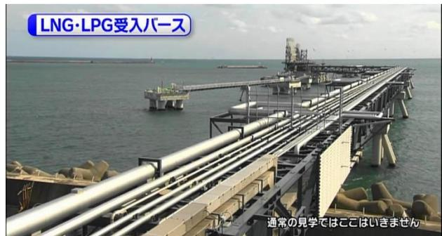
写真4 栈橋のLNGを基地に送るパイプ
