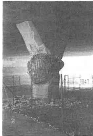
写真 5.5.29 LP3-2 橋脚の被害 (曲げせん断破壊が進み、軸線が完全にずれている) 2)
