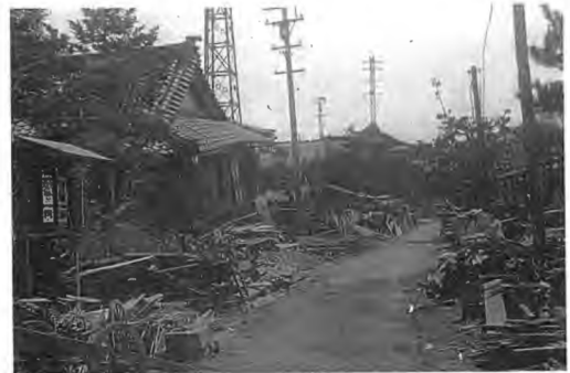
写真 1.1 1948 年福井地震での木造家屋の被害 (小林啓美氏撮影)
