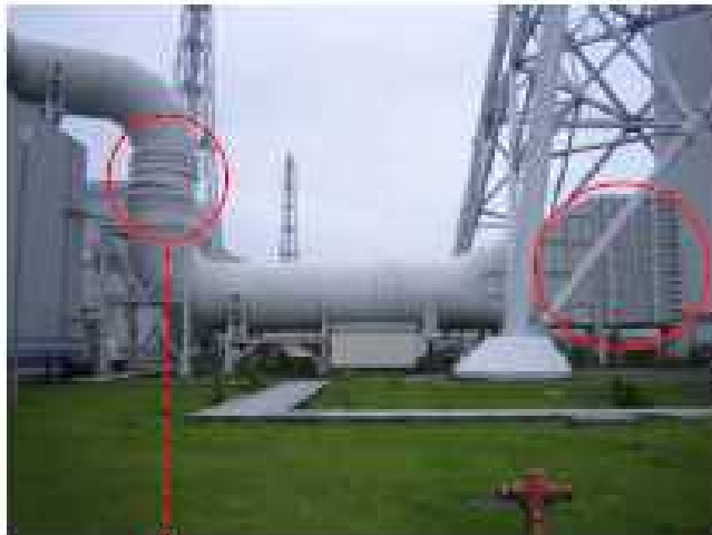
K1 排気ダクト外観
