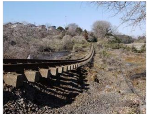
鉄道路盤の流出(ひたちなか海浜鉄道湊)
