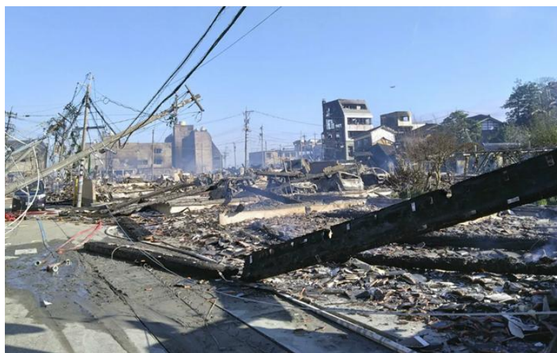
(甲G319号証 44頁 1月2日撮影、輪島市の火災現場)
